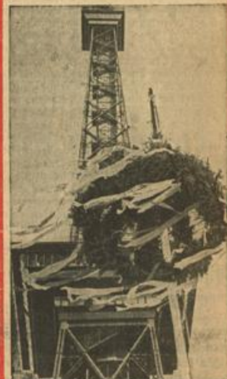
Im Zeichen der Handwerksausstellung. Auf dem Berliner Messegelände fand das Richtfest für die großen Bauten zur Internationalen Handwerksausstellung statt, die Ende Mai eröffnet wird. Unser Bild zeigt die Richtkronen unter dem Funkturm. Weltbild (M)
