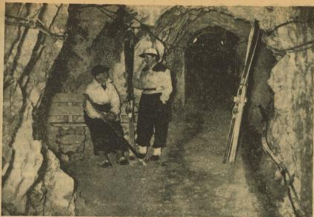
Der neue Tunnel durch den Zugspitzgipfel
