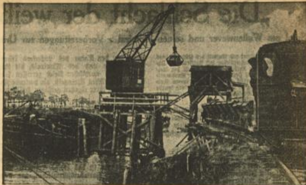
Hier entsteht das stolze Werk der Volkswagenfabrik Weltbild (M) Das Lied der Arbeit erfüllt die Bauplätze von Fallersleben. Bereits Ende 1939 sollen von hier aus die ersten KdF-Wagen ihren Weg ins Reich antreten. Bis dahin ist ein ungeheures Stück Arbeit zu leisten, von der unser Bild einen kleinen Ausschnitt zeigt. Lastkähne haben Bankles auf dem Mittellandkanal herbeigeschafft, der mit Hilfe von Kränen verladen wird.
