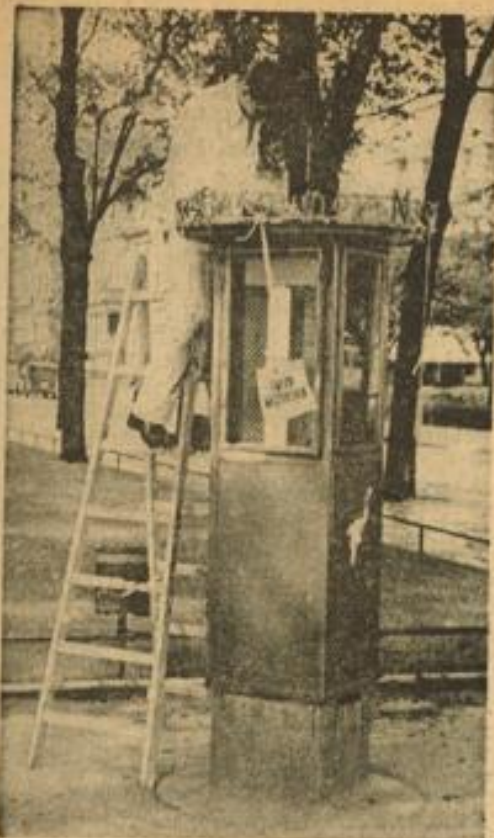
Das Wetterhäuschen am Wasserturm erhält gegenwärtig einen frischen Anstrich. Gleichzeitig hat man auch die meteorologischen Apparate entfernt. Hoffentlich erfolgt die Ueberholung so gründlich, daß in Zukunft nicht wie bisher bei der geringsten Erschütterung jedesmal die Apparate außer Betrieb gesetzt werden. Aufn.: Jütte
