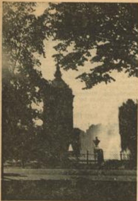
Wasserturm im Gegenlicht Aufnahme: Hans Jütte
