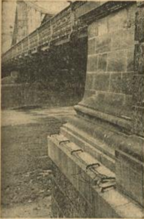
Mit Stacheldraht und Eisenklammern sind die Vorsprünge der Pfeiler der Friedrichsbrücke gesichert, um die überall herumtollende Jugend vor Unbesonnenheiten zurückzuhalten und Unfälle zu vermeiden. Aufn.: Jütte
