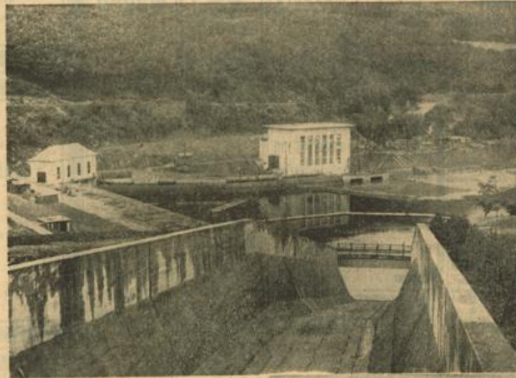
Unten: Die Hochwasser-Entlastungsanlage der Rurtalsperre mit dem Schwammenau-See.
