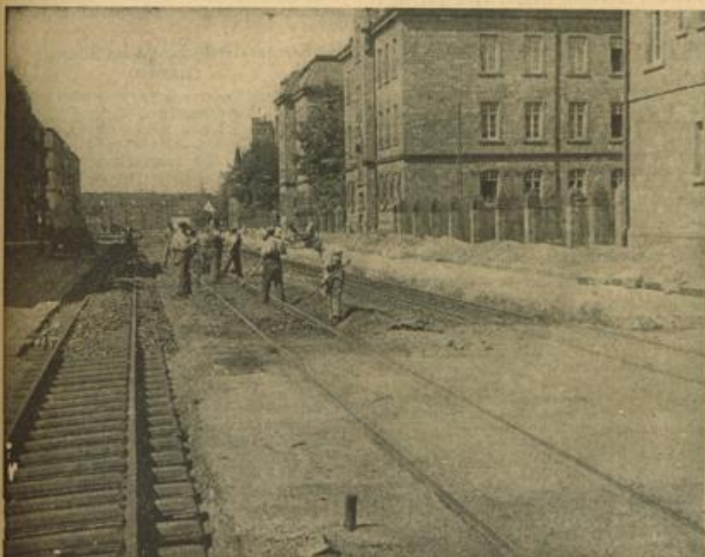
Längs der Artillerie-Kaserne — der früheren 110er-Kaserne — müssen die Straßenbahngleise verlegt werden, da dort die Straße mit zwei Fahrbahnen ausgebaut wird. Links im Bilde sieht man das neue Gleis, das noch eingebaut werden muß und das genau im Zuge der früheren Baumreihe zu liegen kommt. Aufn.: Hans Jütte
