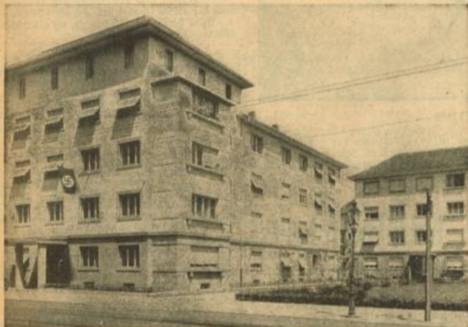
Dachaufbauten gleichen den Höhenunterschied zu den Altbauten aus.
