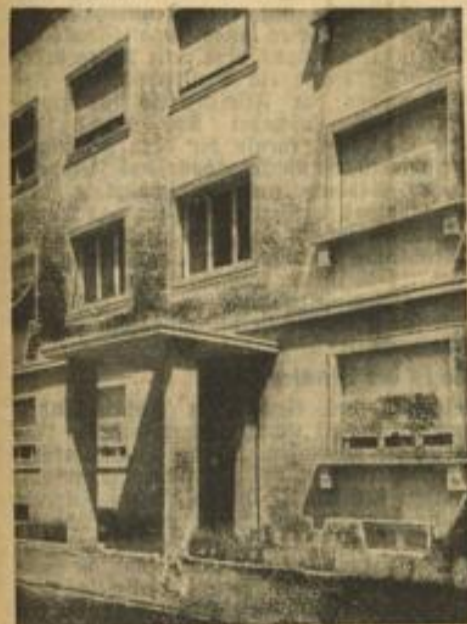
Hauseingang an der Waldparkstraße
