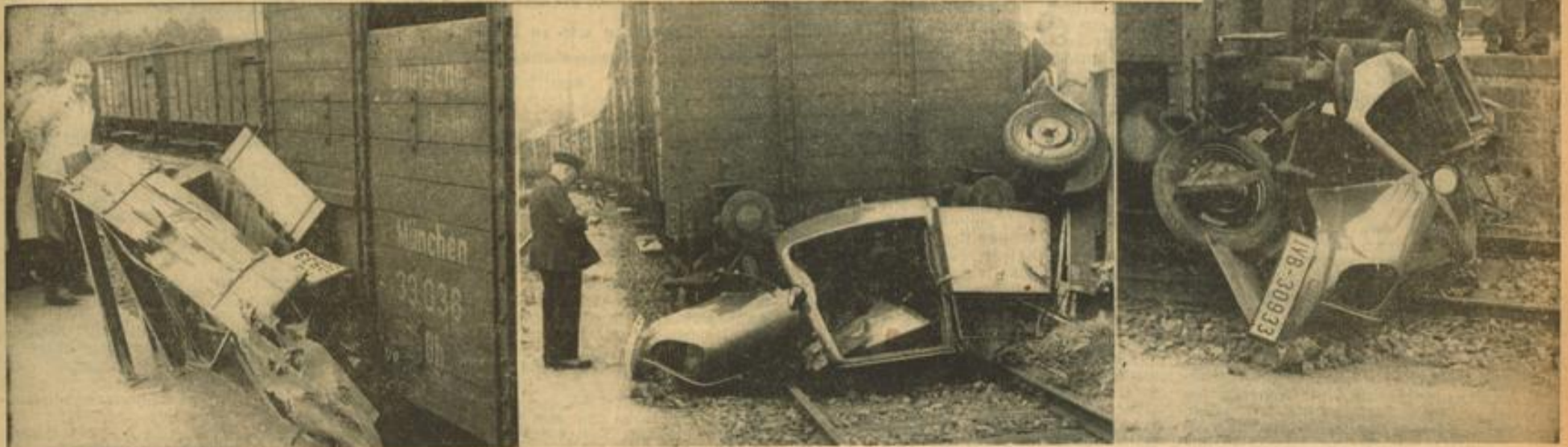
Die ersten Aufnahmen von dem schweren Zusammenstoß am Schlacht- und Viehhof. Links: Der Aufbau des Lieferwagens wurde zwischen Eisenbahnwagen und Laderampe gepreßt. — Mitte: Der Fahrersitz des zertrümmerten Lieferwagens, aus dem der Fahrer unverletzt herausgeholt wurde, nachdem der Rangierzug den Dreiradwagen in dieser Stellung 120 Meter weit geschleift hatte. — Rechts: Ein Blick auf den Lieferwagen von vorn.
