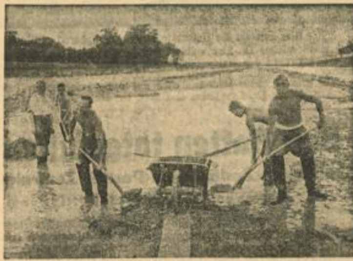
Ein häufiges Bild im Acher-Rench-Gebiet. Der Kraftwagen fährt durch einen See. Arbeitsmänner in hohen Wasserstiefeln heben das Bett des Flußkanals aus. Aufn.: Dietmeier (1), Neubauamt (1)
