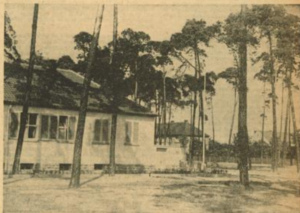
Vorderansicht der Lehrbaustelle am Verlängerten Blütenweg in der Waldhof-Gartenstadt. Aufn.: Jütte.
