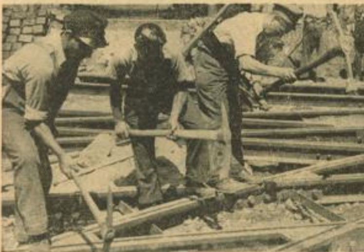
An der Kreuzung Rheinstraße—Luisenring werden zur Zeit umfangreiche Gleiserneuerungsarbeiten vorgenommen.
