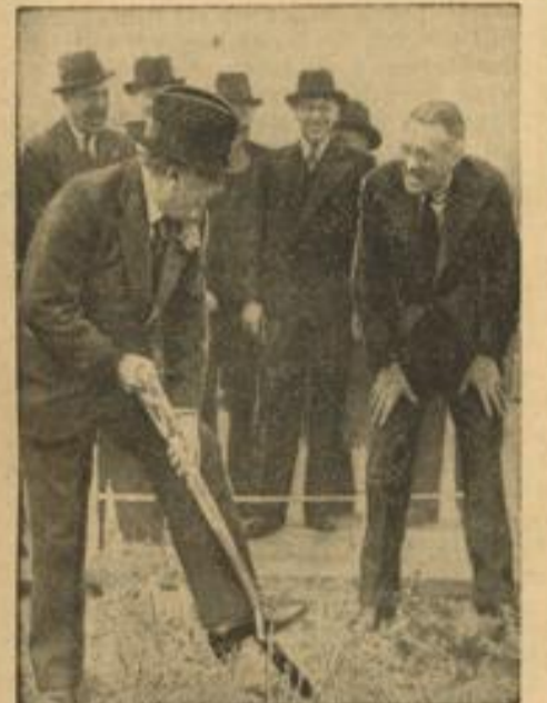
Spatenstich im Zeichen der Aufrüstung Der britische Luftfahrtminister Sir Kingsley Wood vollzog, wie berichtet, in der Nähe der Stadt Birmingham den ersten Spatenstich zum Bau der größten britischen Flugzeugfabrik, für die als Anfangsauftrag bereits 1000 Kampfflugzeuge bestellt sind. (Associated-Press-M)
