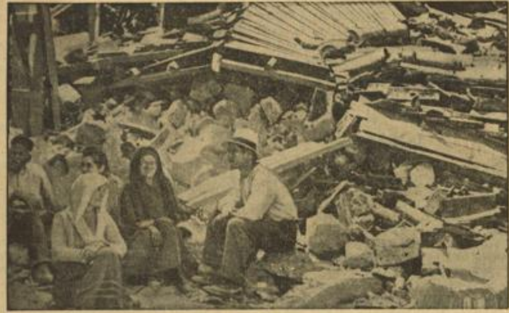
Das schwere Erdbeben vernichtete ihr Heim Die griechische Provinz Attika wurde von einem heftigen Erdbeben heimgesucht. Rund 20 v. H. der Häuser wurden völlig zerstört, 40 v. H. sind nicht mehr bewohnbar. Unser Bild ist in einem Dorf in der Nähe Athens aufgenommen und zeigt Einwohner des Ortes auf den Trümmern ihres Hauses. — Weltbild (M)
