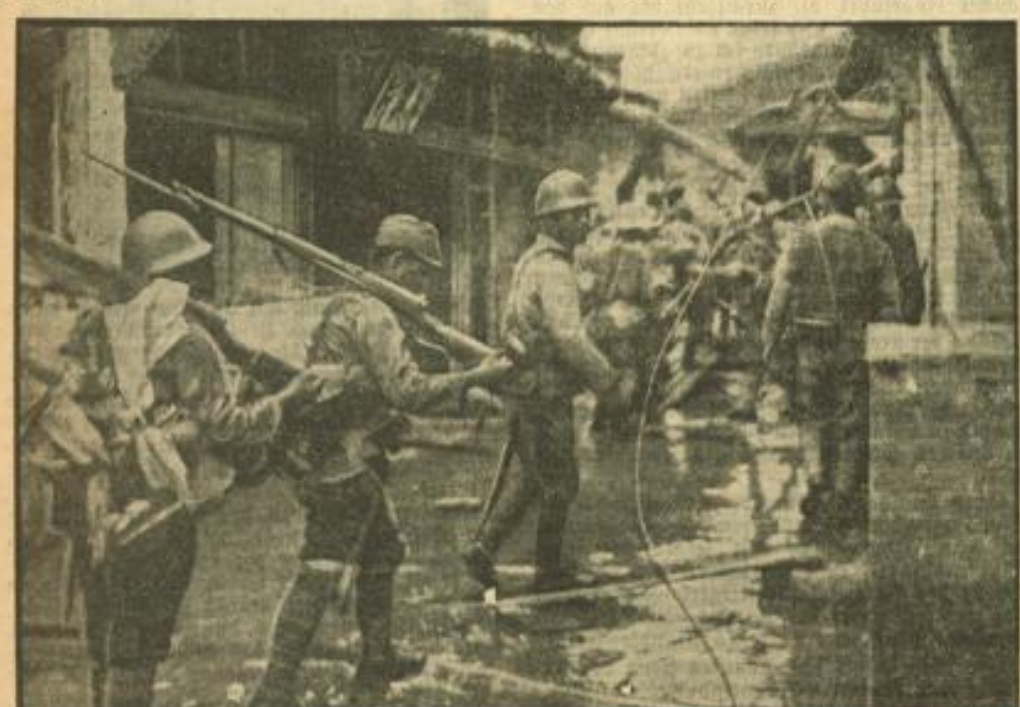
Japanische Soldaten im Kampf mit der Ueberschwemmung Japanische Soldaten passierten bei ihrem Vorgehen ein überschwemmtes Dorf auf Bretterpfaden. Bei ihrem Vormarsch in Süchina werden die Truppen durch den Strom der Flutflüede stark behindert. Weltbild (M)
