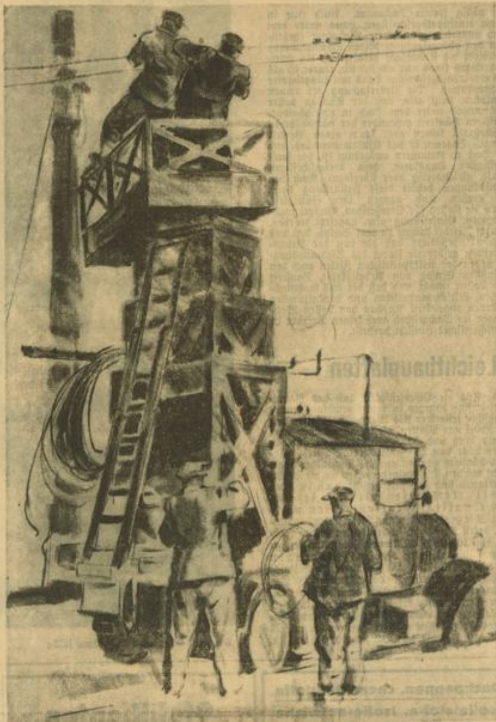
Ohne jegliche Verkehrsstörungen vollziehen sich die Arbeiten an dem weitverzweigten Oberleitungsnetz, das in Ordnung gehalten werden muß.
