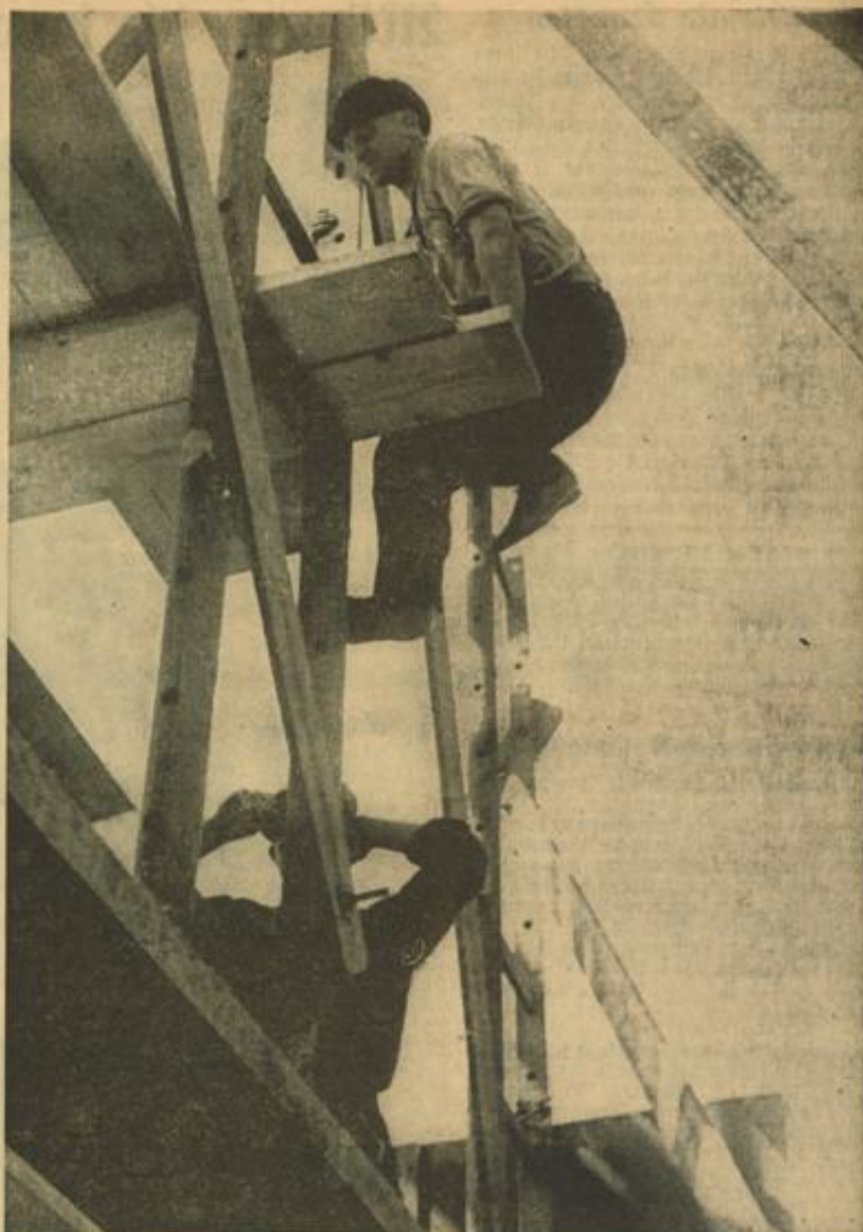
Auf dem Baugerüst in luftiger Höhe
