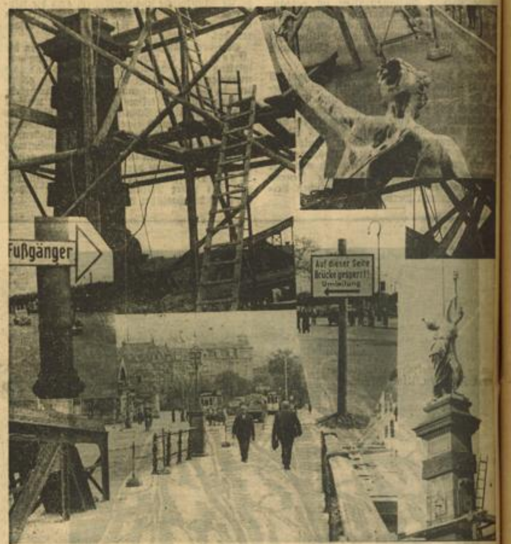
Die Pfeiler der Friedrichsbrücke sind restlos niedergebri
