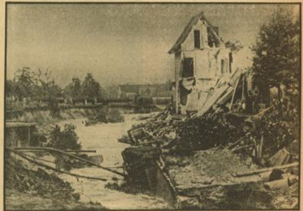
Der HausEinsturz in Bottrop, dessen Ursache das fürchterliche Unwetter der letzten Tage war. In fast allen Teilen des Reiches haben Unwetter großen Schaden angerichtet. Unser Bild zeigt ein durch Wassermassen zerstörtes dreistöckiges Haus in Bottrop im Ruhrgebiet.
