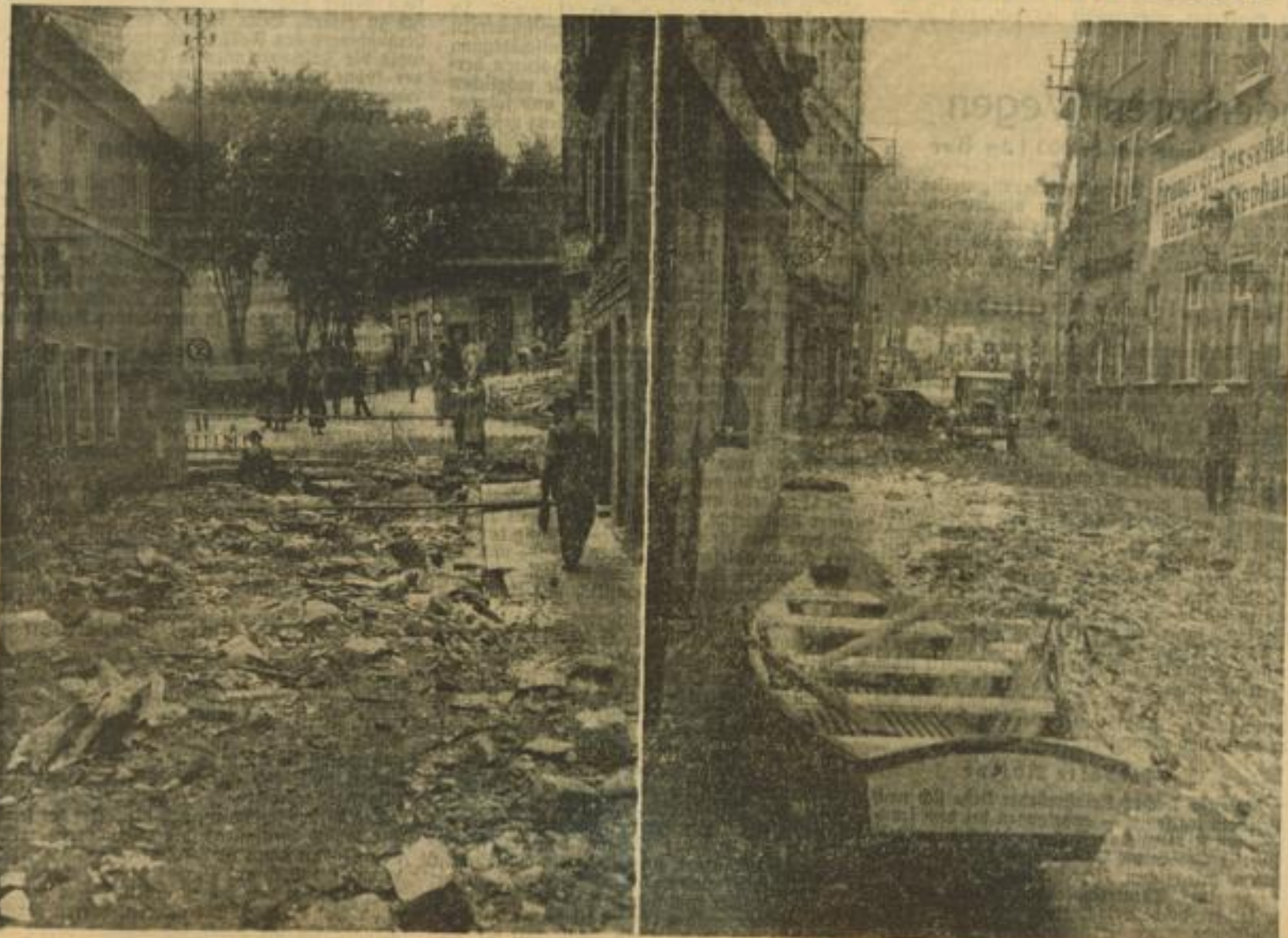
Wie sich jetzt übersehen läßt, sind die Verwüstungen des Hochwassers an der Glatzer Neiße von einem geradezu katastrophalen Ausmaß. Nicht weniger als 1800 Häuser standen in Glatztagelang unter Wasser. Mehrere Häuser und vier Brücken sind eingestürzt. Unsere Bilder geben einen Eindruck von den folgenschweren Verwüstungen in den Straßen von Glatz. (Presse-Bild-Zentrale-M)
