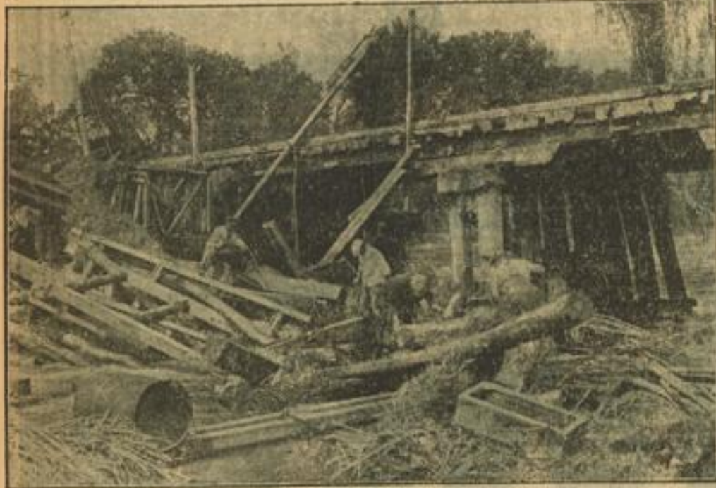
Die Aufräumarbeiten im Uberschwemmungsgebiet sind in vollem Gange
