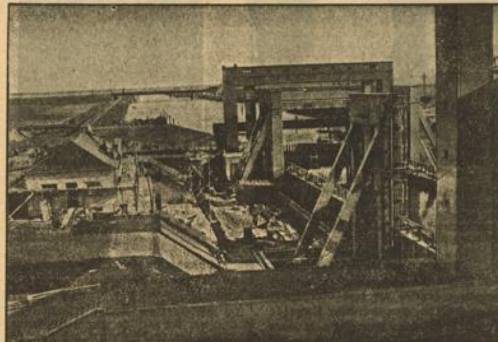
Der Mittellandkanal, die Drehschleife der deutschen Binnenschifffahrt Weltbild (M) Am 16. Oktober werden zum ersten Male 1000-Tonnen-Kähne, die aus dem Westen kommen, vom Schiffshebewerk Rothensee bei Magdeburg 19 Mtr. tief auf das Niveau des Abstiegkanals gesenkt werden, der sie dann nach Magdeburg bzw. in die Elbe bringt. Damit findet eine 82 Jahre lange Entwicklung durch die Initiative des nationalsozialistischen Staates ihren erfolgreichen Abschluß. Unser Bild zeigt einen Blick auf das Schiffshebewerk Rothensee. Rechts der Abschluß des Kanals, im Mittelgrund der nach Magdeburg und in die Elbe führende Abstiegkanal, im Hintergrund die Reichsautobahnbrücke der Strecke Berlin-Hannover.
