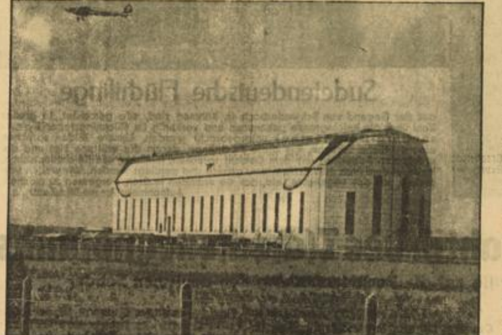
Die neue Luftschiffhalle im Flughafen Rhein-Main fertig. Die neue Luftschiffhalle, die in ihren Ausmaßen einen imposanten Eindruck auf den Beschauer macht...
