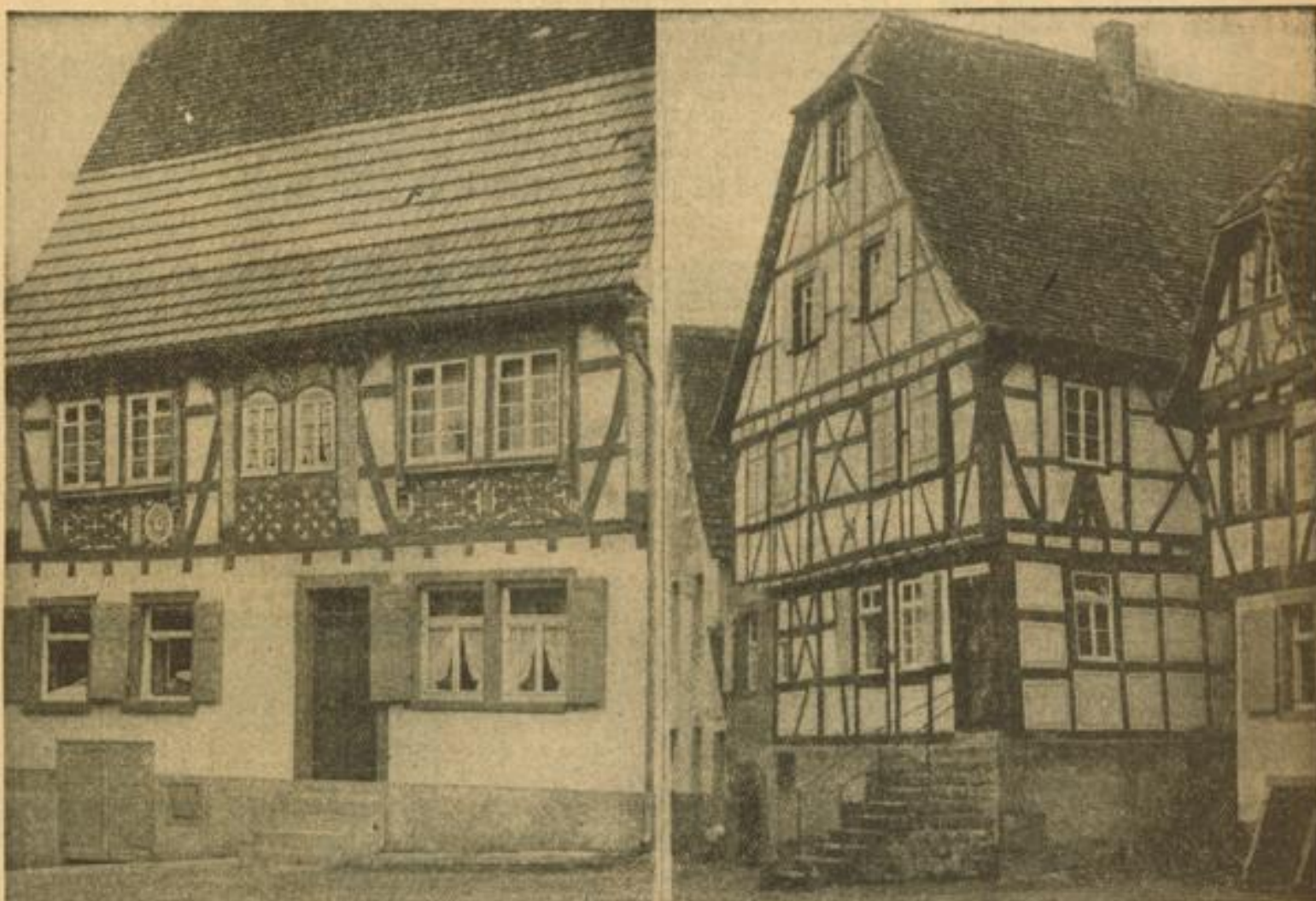
In dem Neckarstädtchen ist man seit längerer Zeit schon emsig dabei, die schmucken Fachwerkhäuser so zu zeigen, wie sie einst von fleißigen Handwerkern gebaut wurden. Viele Häuser waren überfärbt mit „modernen“ Farben zu einer Zeit, da man glaubte, das alte Fachwerkhaus passe nicht mehr in die Zeit! Heute bilden sie wieder eine Zierde der Dörfer und Städte. Aufn.: Imhoff (2)
