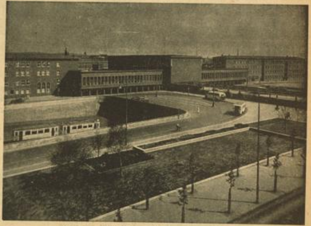
Der monumentale Neubau des Hauptbahnhofs Duisburg
