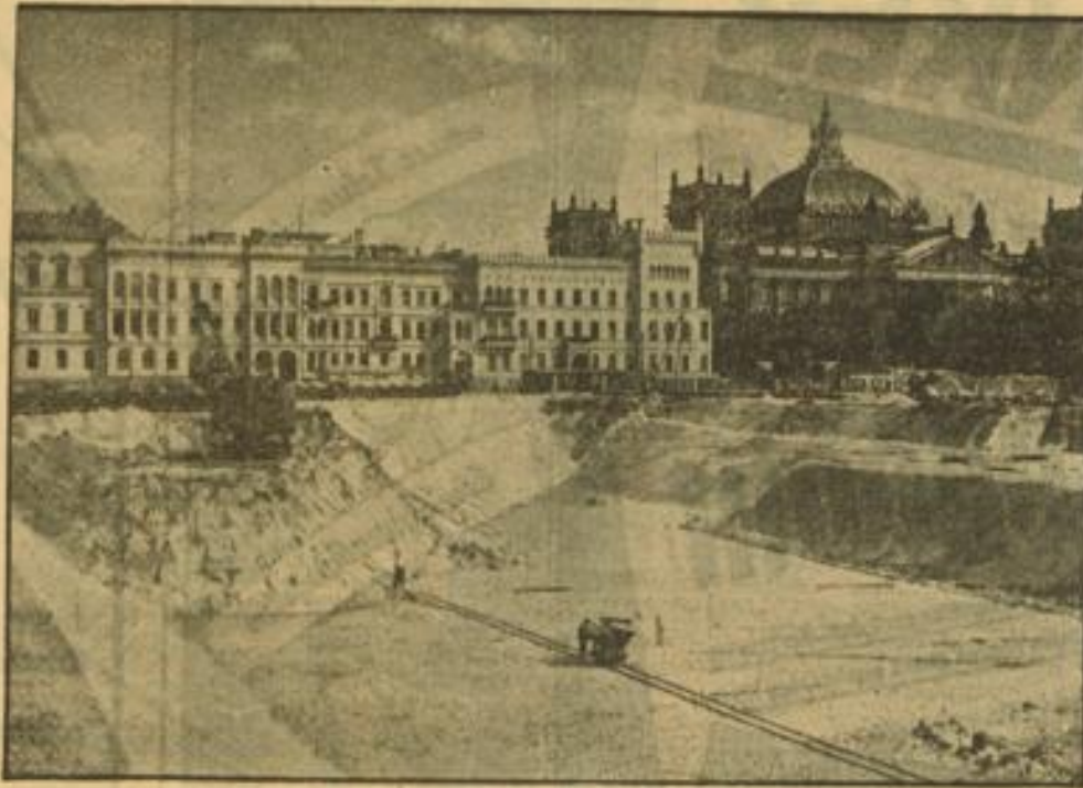
Die Umgestaltung der Reichshauptstadt. Beginn der Arbeiten für den Spreedurchstich am Königsplatz. Im Vordergrund das neue Weltbild (M)
