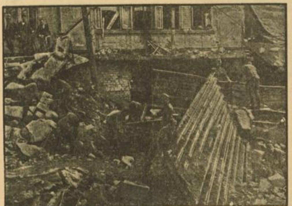
Deutsche Soldaten räumen auf Pioniere beseitigen die Trümmer einer Brücke bei Schönau, die von den Tschechen in blinder Zerstörungswut in die Luft gesprengt worden ist. Weibbild (M)
