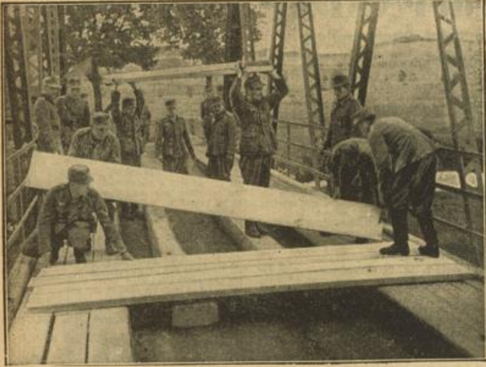
Das Aufbauwerk in den betroffenen Gebieten in vollem Gange
