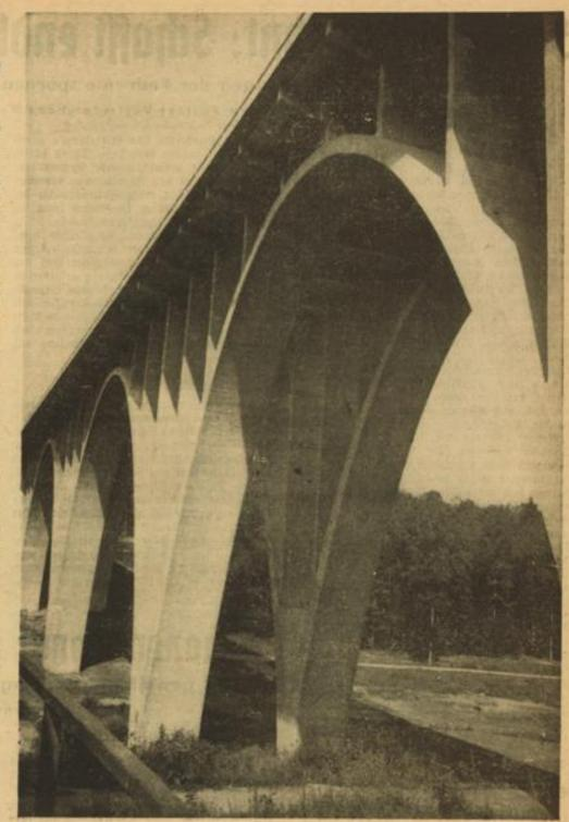
Die Rohrbachbrücke der Reichsautobahn auf der Strecke Stuttgart-Heilbronn Die nunmehr fertiggestellte 360 Meter lange Rohrbachbrücke auf der Reichsautobahnstrecke Stuttgart-Heilbronn. Die Höhe der Bogen betragen 36 Meter. Pressebildzentrale
