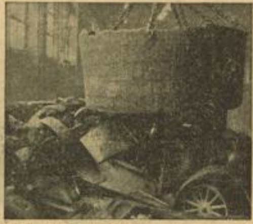
Schrott wird zu Paketen zusammengepreßt und für die Wiederverarbeitung im Stahlwerk hergerichtet
