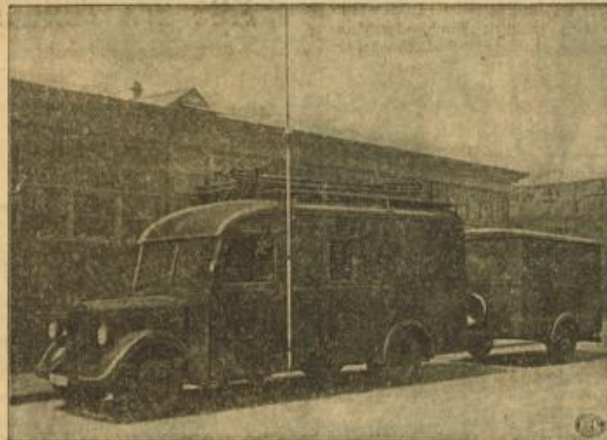
Lautsprecherwagen mit Anhänger (Gesamtsprecheleistung 200 Watt)
