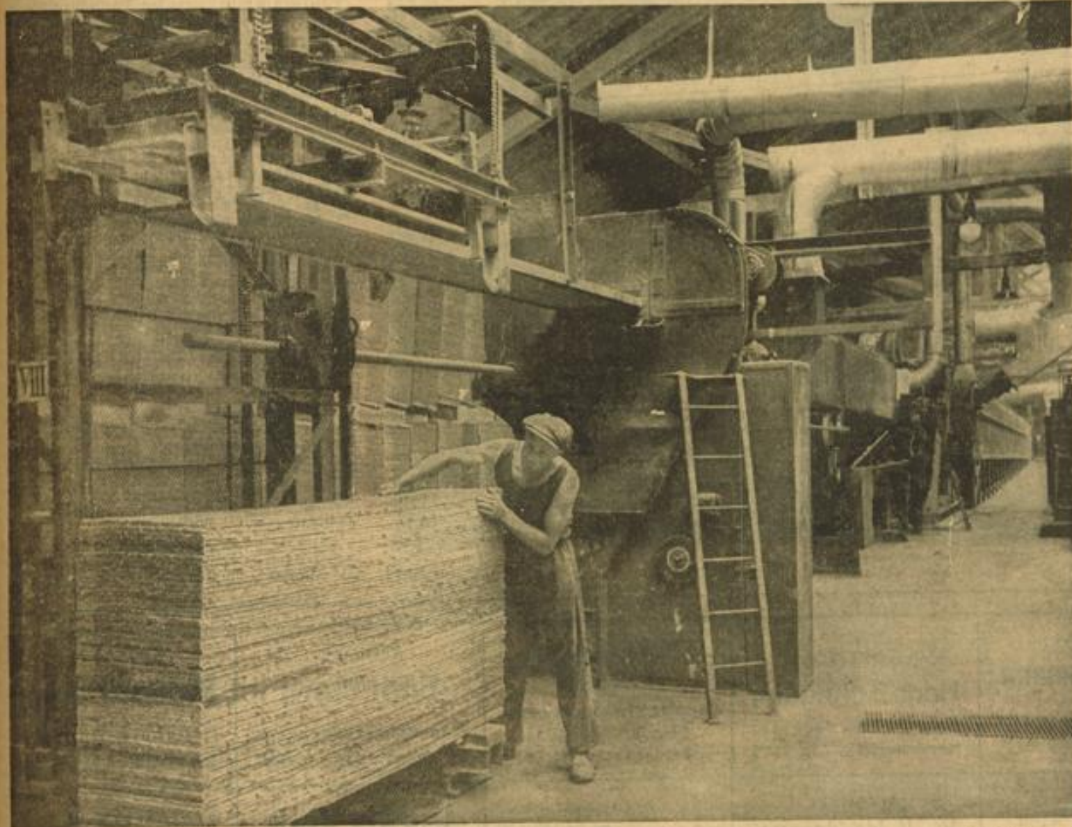
Der automatische Stapler. Bis zu 70 Meter lang ist die oben durchlaufende Bandformmaschine
