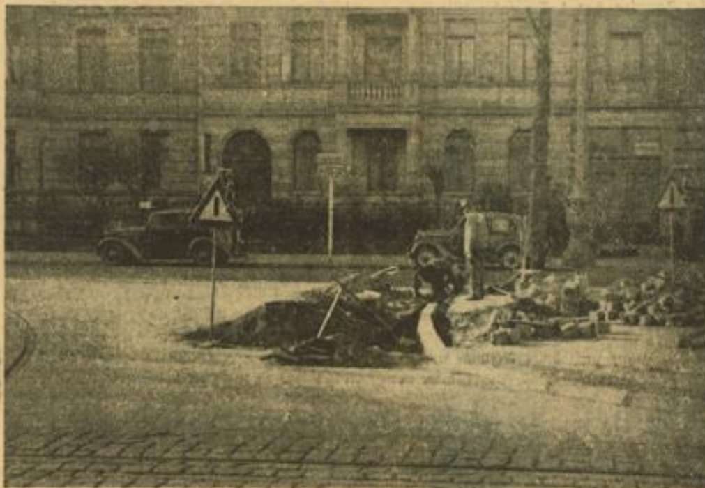
Die Ecke an dem Mittelstreifen des Friedrichsringes an der Einmündung der Goethestraße ist nun in den letzten Tagen „abgerast“ worden, nachdem man zuerst den auf der Ecke stehenden Baum gefällt hat. Die Einmündung der Goethestraße in den Ring erfolgt jetzt ohne Hindernis. Unser Bild zeigt die letzten Arbeiten an der Randsteinversetzung. Ganz links sieht man die Straßenbahngleise, die bisher zu nahe an der Gehwegkante verliefen. Unglücklich dort, wo auf dem Bild das Vorsichtszeichen steht, befand sich früher die Ecke des Randsteins, so daß zwischen diesem und einem gleichzeitig die Stelle erreichenden Straßenbahnwagen, keine Fahrzeuge hindurchkamen. Diese Mißstände beseitigt ohne weiteres die zurückversetzte Ecke. Aufnahme: Jütte
