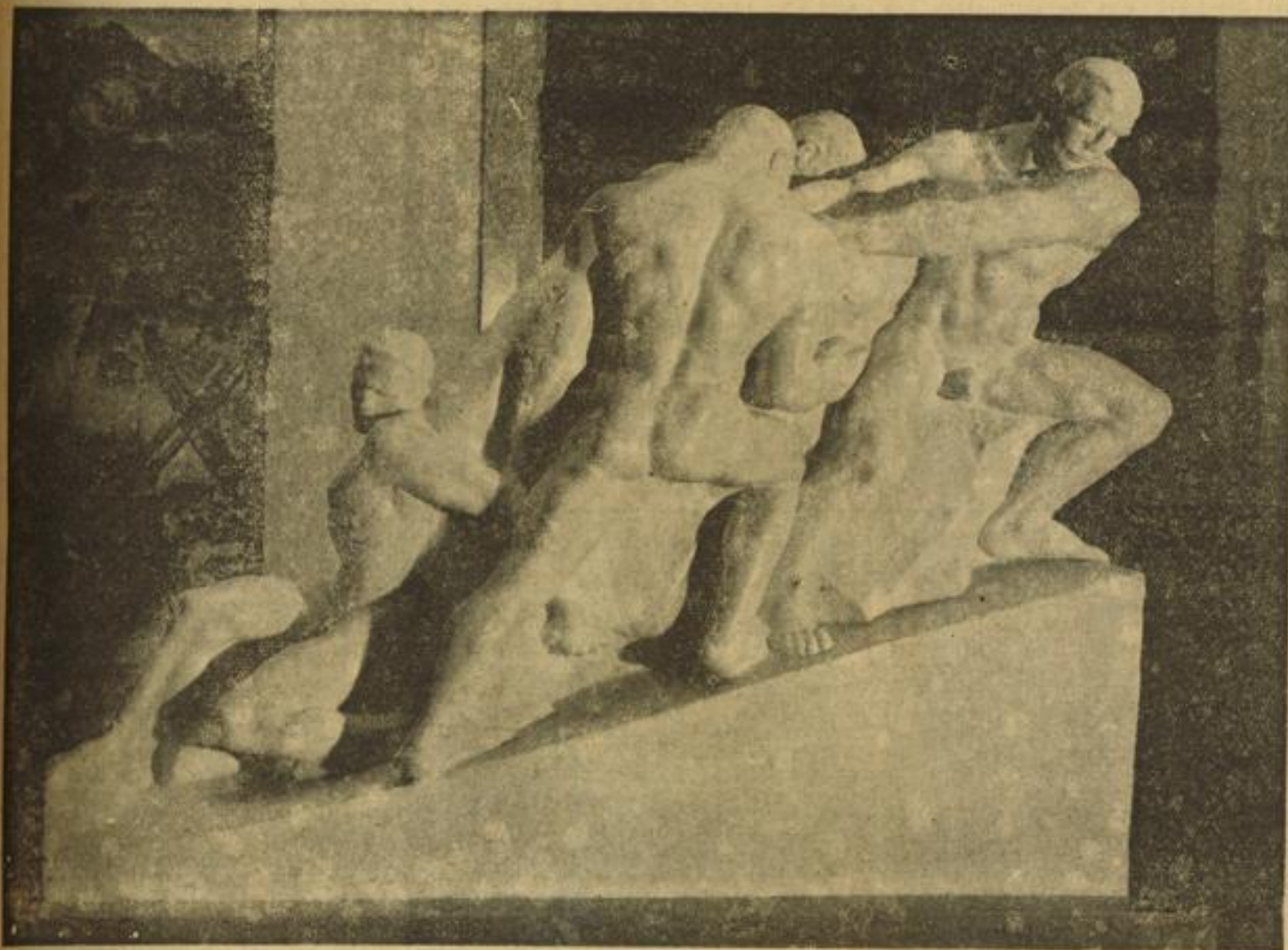
Riesige Arbeitergruppe auf der Reichsautobahn
