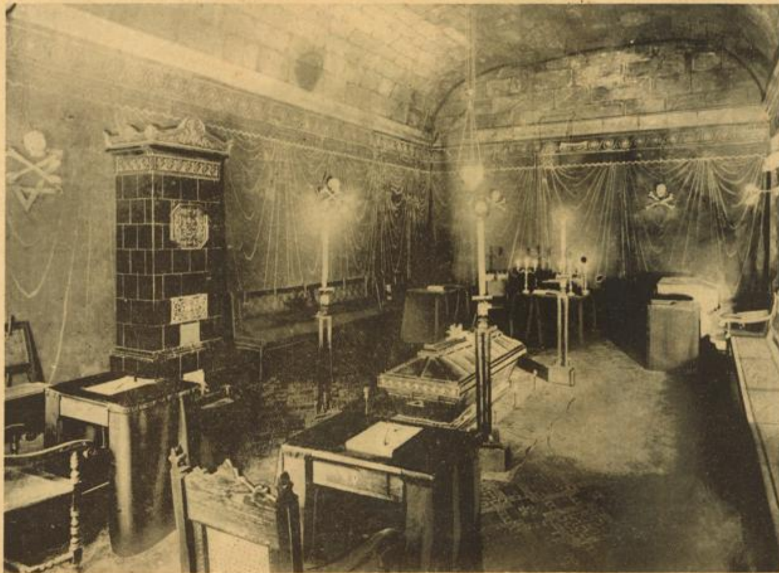
Alter Zustand des Meistertempels 3. Grades, wie er vorgelunden wurde
