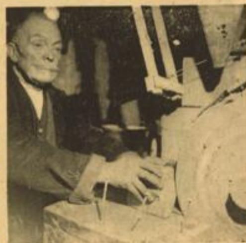
Beim Schneiden eines Sprudelsteinklotzes mit der Stahlscheibe
