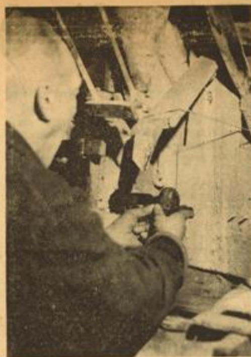
Der Lederballen der Poliermaschine gibt dem Sprudelstein den bewundernden Glanz. Aufn.: Vorfasser (3)
