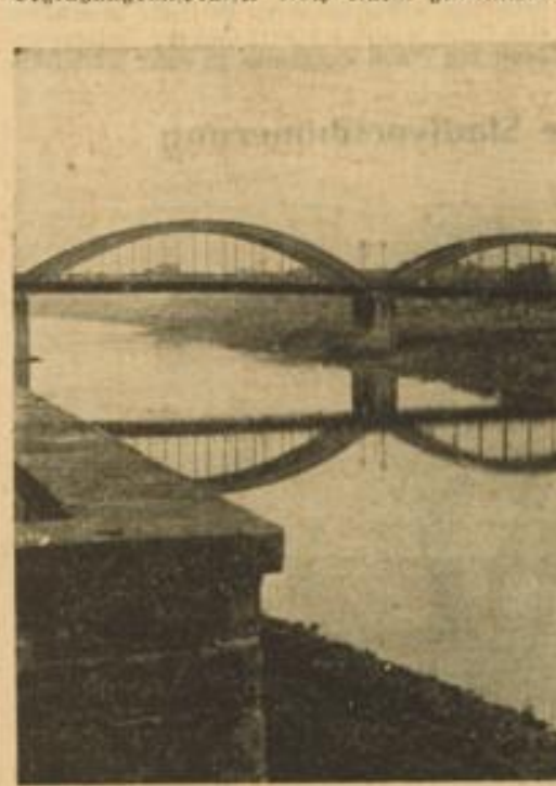
Blick von der neugeschaffenen Terrasse des Seckenheimer Schlössels auf die Robert-Wagner-Brücke und auf Ilvesheim.
