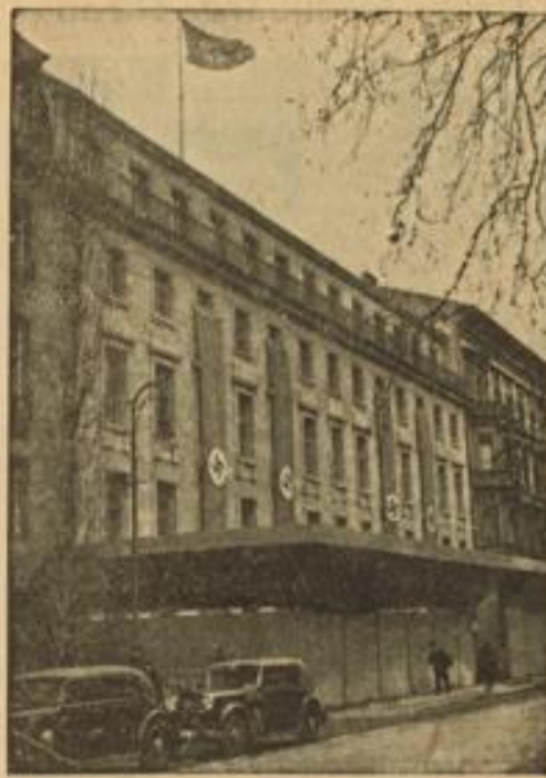
Richtfest für die Erweiterungsbauten des Oberkommandos der Wehrmacht
