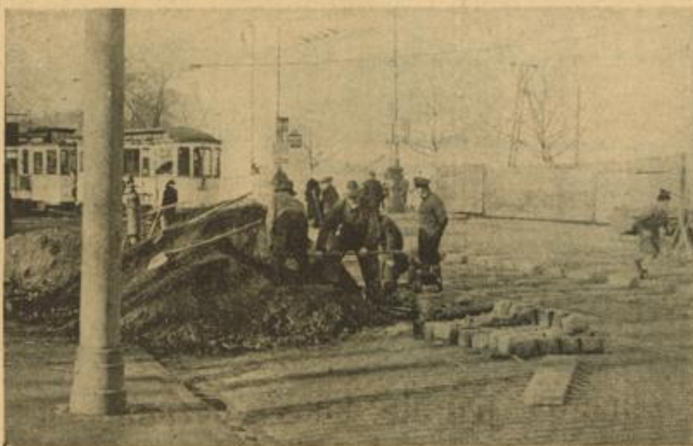
An dieser Stelle entsteht in wenigen Monaten der neue große Rondellplatz zwischen Breite Straße und Friedrichsbrücke. Gegenwärtig ist man beim Buddeln und Verlegen von Leitungen, so daß der Straßenverkehr in Richtung Friedrichsring vor U 1 umgeleitet werden muß. Aufn.: Jütte
