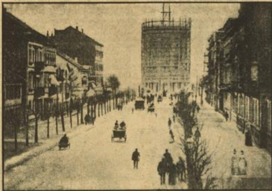
Anno 1884: Der Wasserturm im Bau Eine Aufnahme aus dem gemühtlichen Alt-Mannheim. — Im Vordergrund das hohe Rundgerüst. Aufnahme aus Privatbesitz
