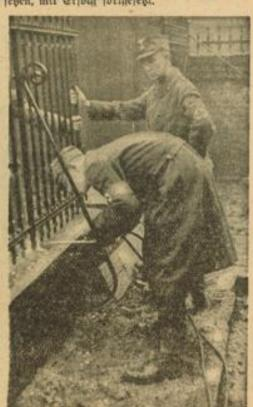
rachmännisch wird die Eisenstange mit dem Schneidbrenner durchgeschnitten,
