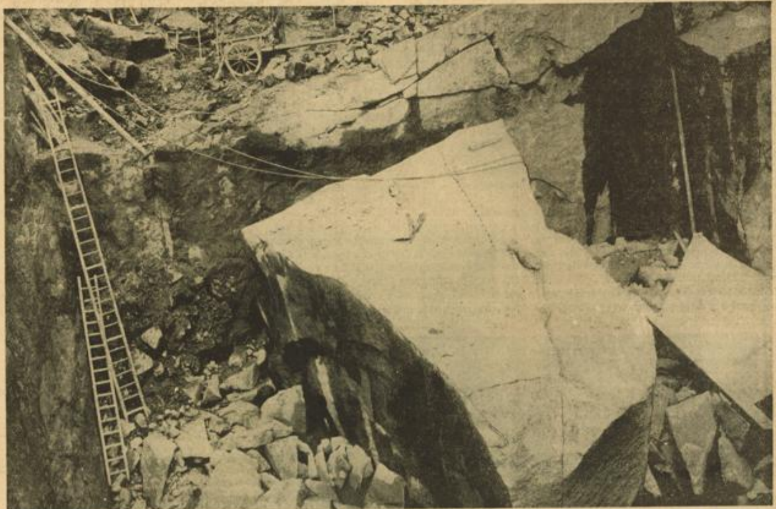
Ein 3000 Zentner schwerer Stein wurde durch Sprengungen freigelegt.
