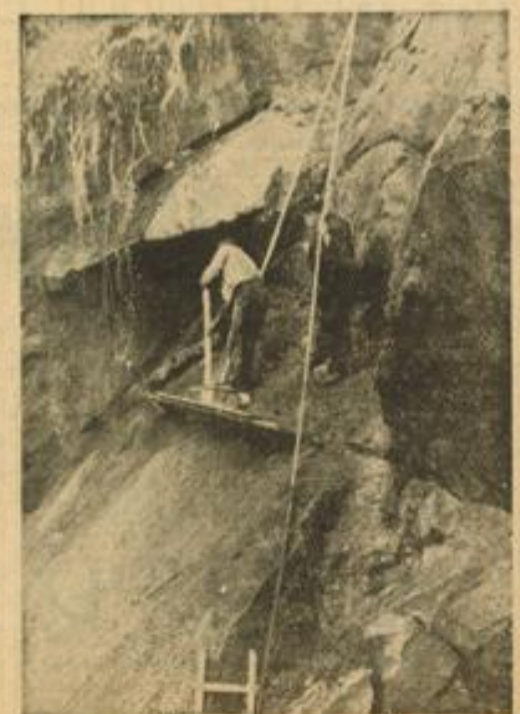
Das Sprengpulver wird gelegt.
