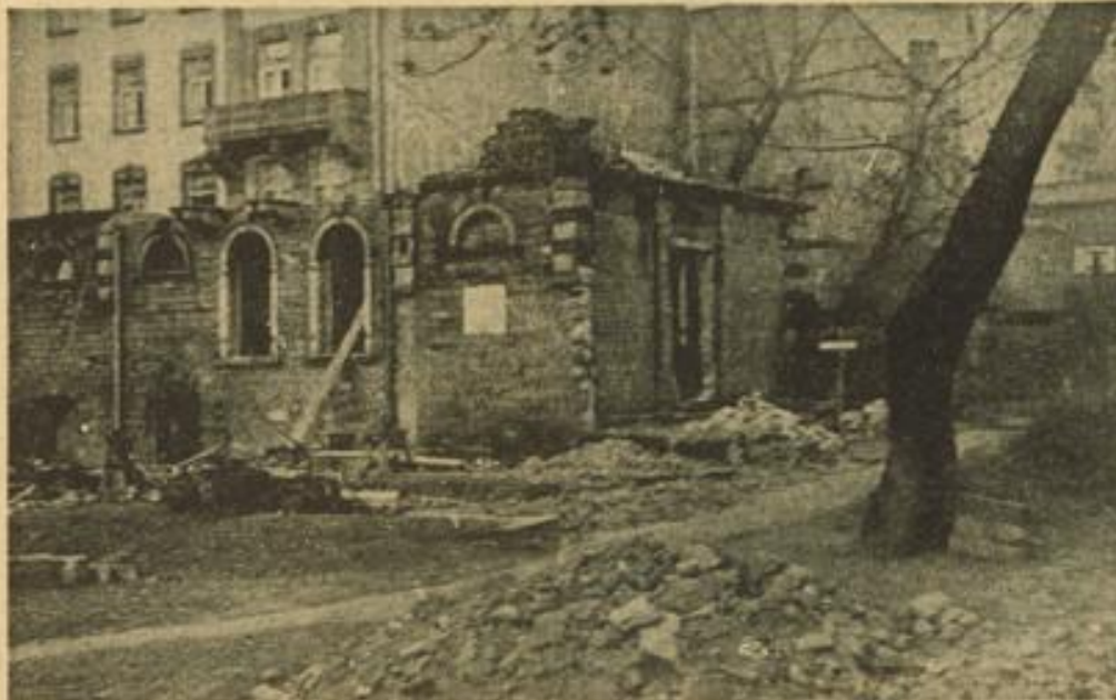
Im Laverschen Garten gehen die Umgestaltungsarbeiten planmäßig vorwärts. Das letzte der beiden Gartenhäuschen, die der Neuplanung im Wege standen, fiel nun auch der Spitzhake zum Opfer. Jetzt erst kann man die Weiträumigkeit dieser Anlage richtig erkennen und ungefähr ahnen, wie schön diese Grünanlage nach ihrer Fertigstellung einmal sein wird.
