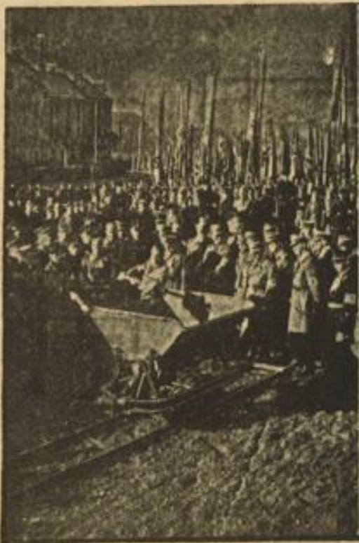
Der Stellvertreter des Führers vollzieht den ersten Spatenstich zum größten Siedlungsvorhaben Deutschlands.
