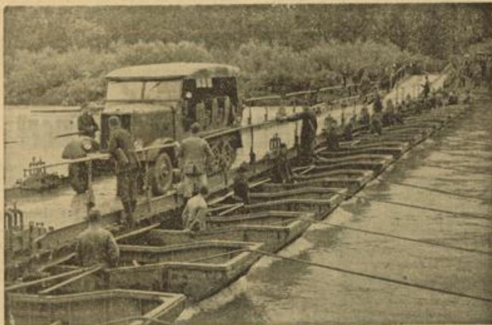
Pioniere beim Brückenbau Archivbild (M)
