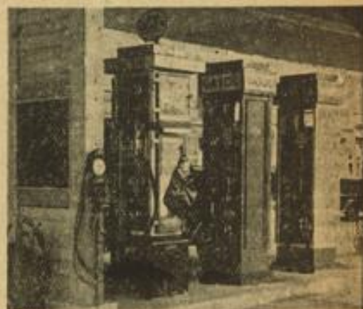
Die automatisch betriebenen Zapfsäulen an der Großtankstelle
