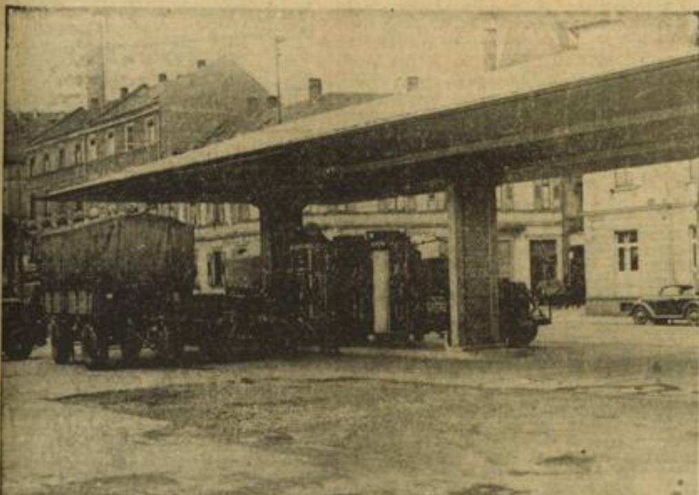
Die Großtankstelle Ecke Hafenstraße und Jungbuchsstraße mit der kühnen Ueberdachung.
