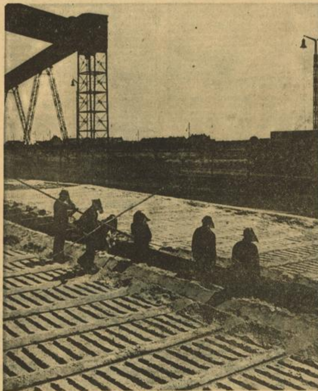
Der deutsche Arbeiter schallt! Hochofenabstich in die Gießbetten des Werkes
