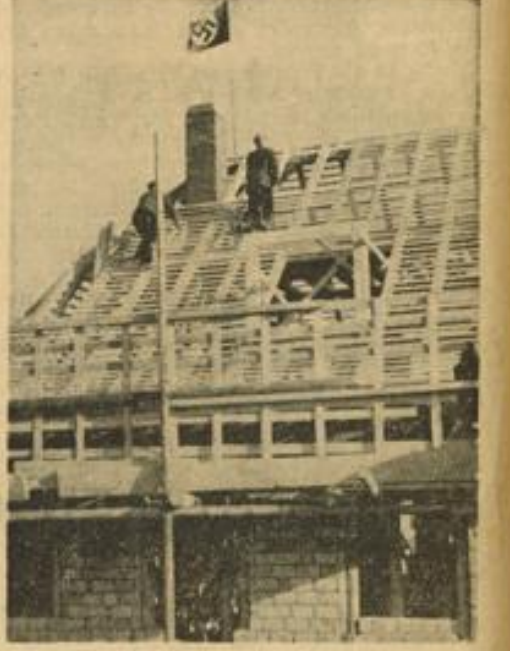
Bald ist der Bau schlüsselfertig. Aufn.: W. M. Schatz, PBZ
