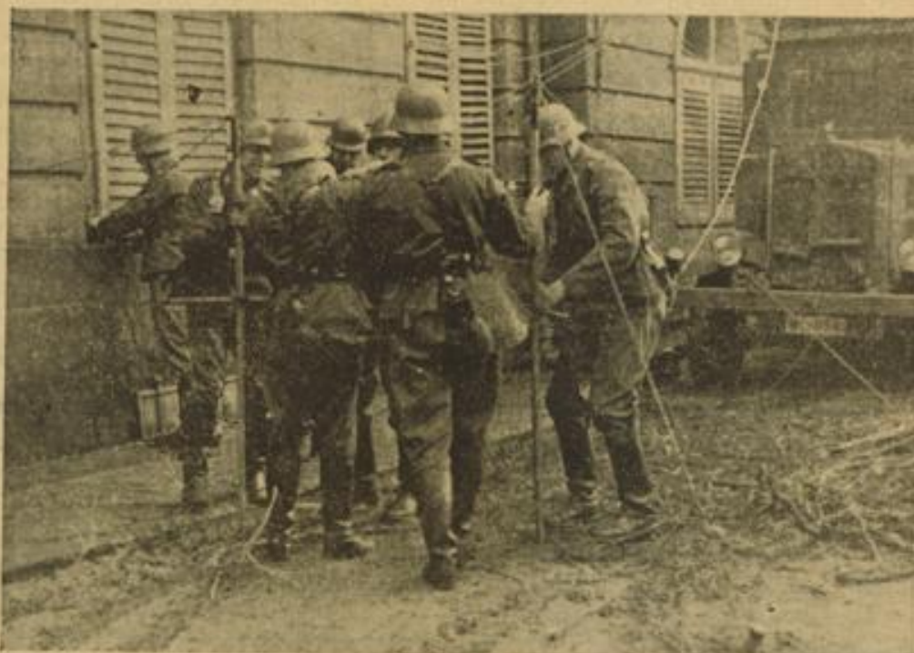
Noch ein Bild aus der Arbeit der Luftnachrichtentruppe: ein Fernsprechbautrup. Aufn.: Jütto
