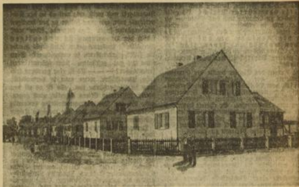
Fertige Eigenhelme des 1. Bauabschnitts der Siedlung
