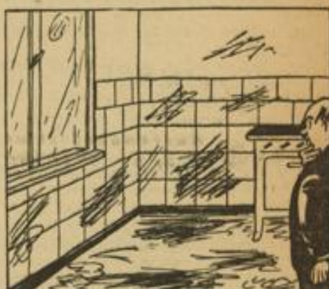
Nun zieht man in das neue Haus, doch oh, wie sieht die Küche aus! Zwar fertig ist der Malermeister, doch haften Farbe noch und Kleister.
