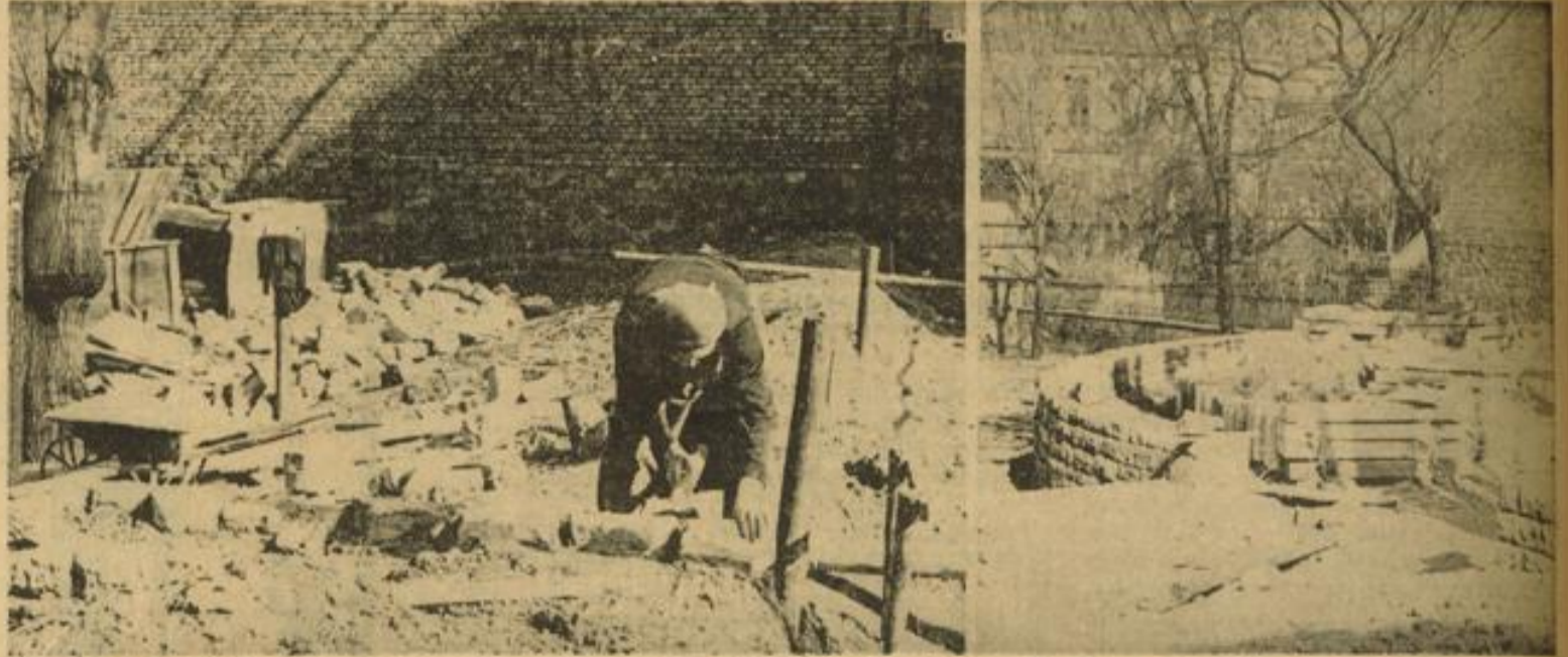
Auf dem Gelände der Lauerschen Gärten ist man jetzt eifrig mit der Neugestaltung beschäftigt. Schon kann man die Weiträumigkeit der neuen Anlage erkennen...
