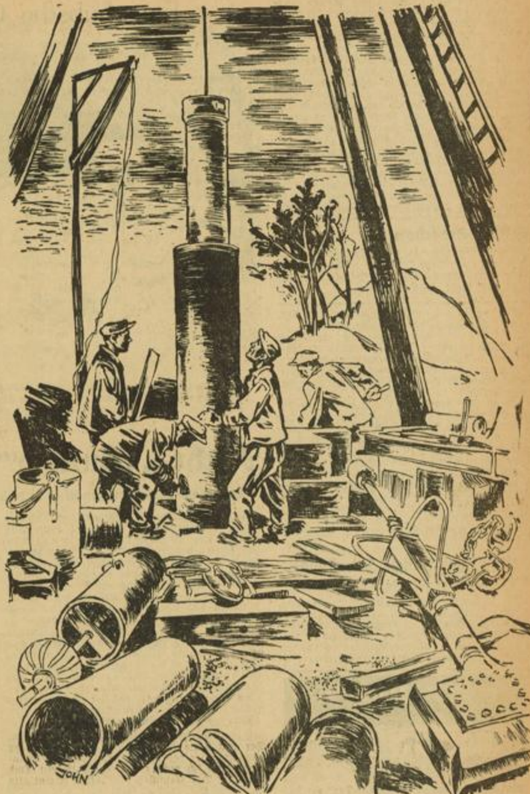
Hier sieht man, wie der Pumpenbohrer ins Bohrrohr einfährt. Rechts im Vordergrund der Riesenmeißel für harten Boden, die sogenannte Freifallmaschine.
