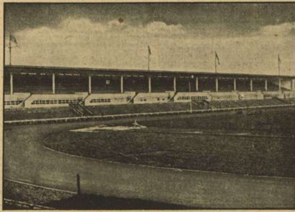
Blick auf die Bremer Kampfbahn, wo am 23. Mai der Fußball-Länderkampf Deutschland - Irland zum Austrag gelangt. Man sieht die steil aufragenden Ränge und die Eingänge zu den Umkleide- und Baderäumen unter der Tribüne.
