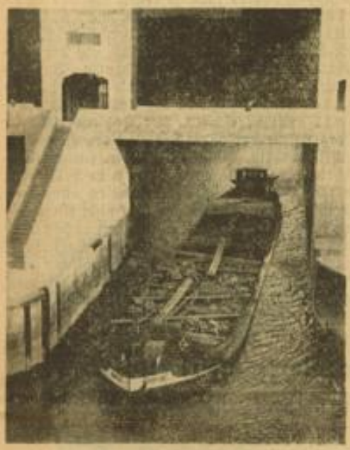
In der Kanalschleuse
