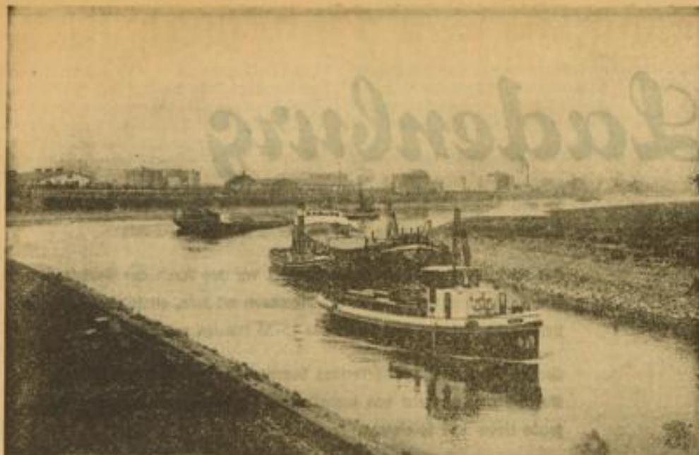
Einfahrt zur Kammer Schleuse
