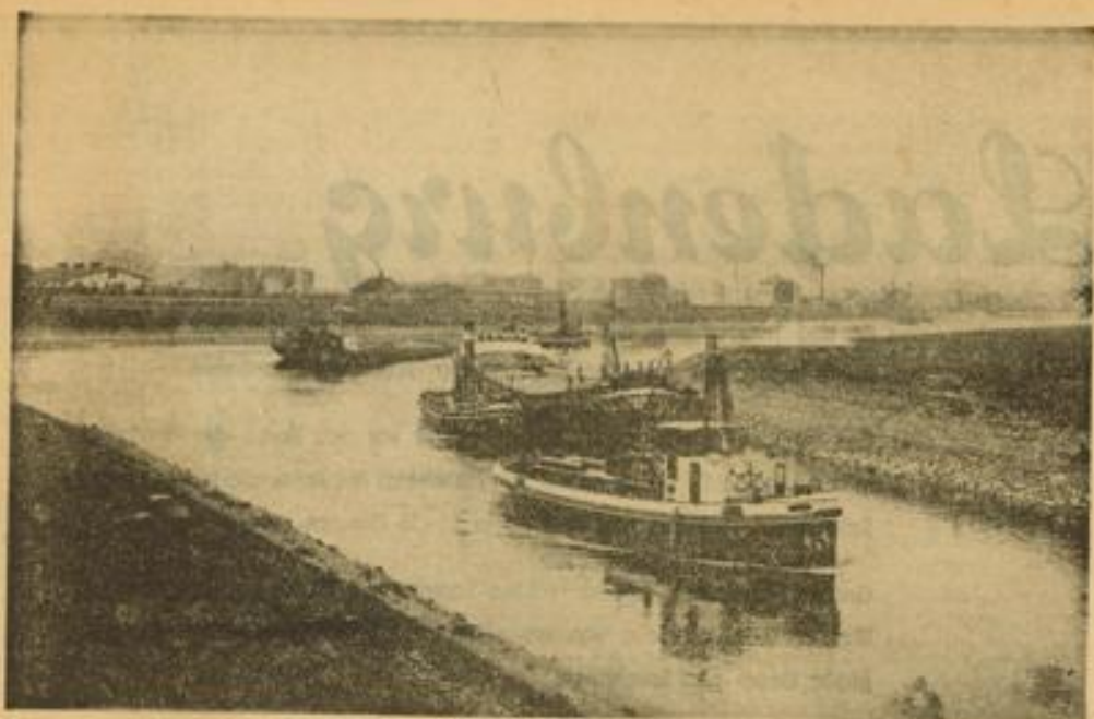
Einfahrt zur Kammerschleuse
