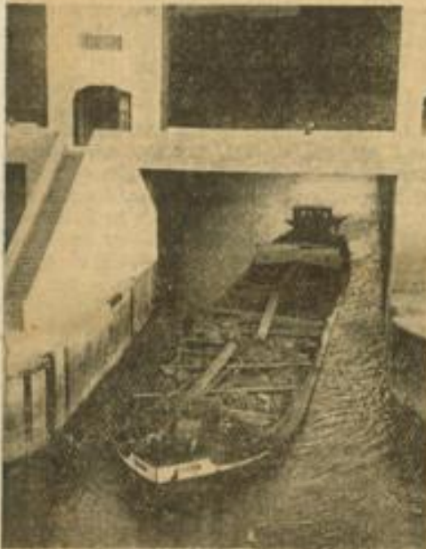
In der Kanalschleuse
