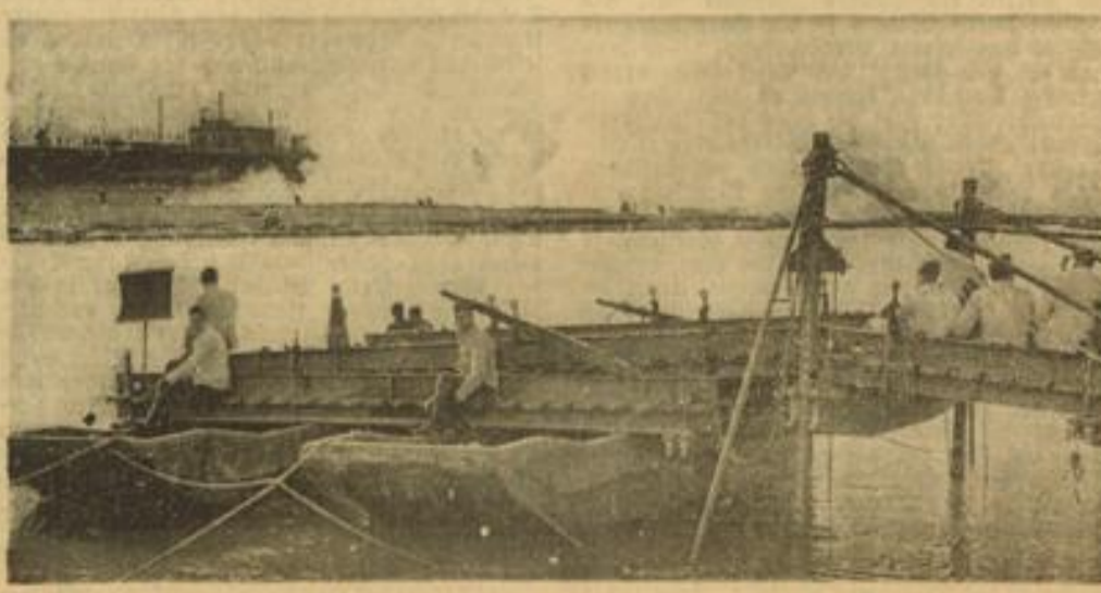
Im Schutz des künstlich erzeugten Nebels dringen Pioniere auf dem jenseitigen Flußufer vor, auf das sie mit Floßsäcken übersetzt hatten. Aufn.: Hans Jütte
